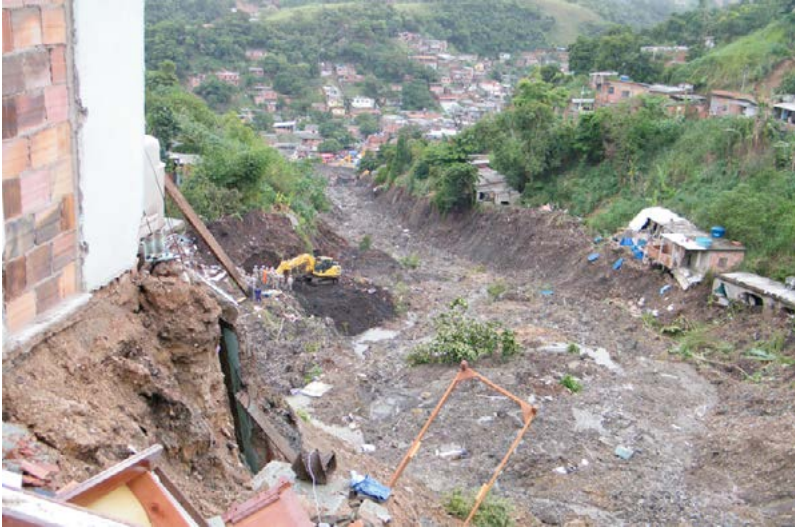
Deslizamento de terra
